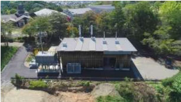
内子町森林組合に出材された原木約3,600t/年の間伐未利用材により製造された木質ペレットを燃料にして330kWの発電を行い、発電時に発生する熱を隣接する内子町龍王公園内の「オーベルジュ内子」と「フィットネスクラブ Ryuow」の2施設へ供給している。
